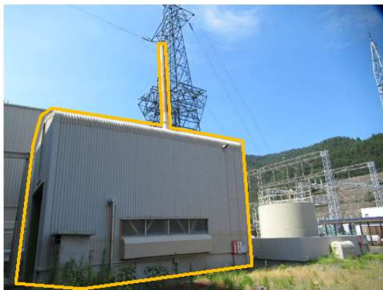
補助ボイラー
